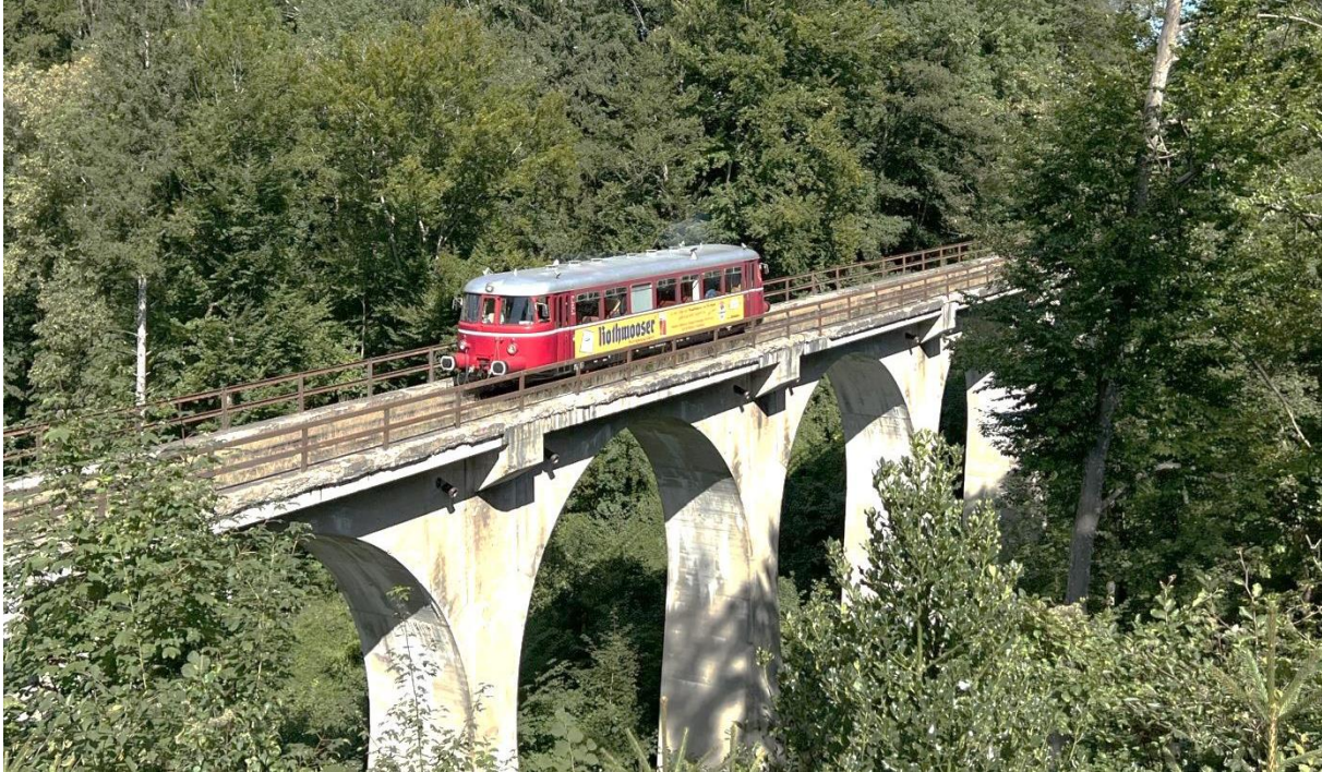
MAN-Triebwagen VT 26 der Chiemgauer Lokalbahn auf Ameranger Viadukt
